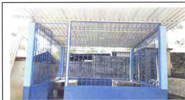
Foto 3: Sustitución de lámina por lámina troquelada Aluzin calibre 26 en cocina; sustitución de estructura de soporte de madera por metal en cocina
