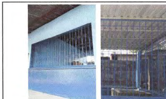
Foto 4: Mantenimiento de estructura de metal de aula y sustitución de balcon de metal a cocina
