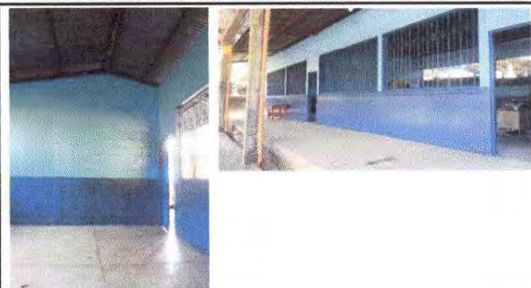
Foto 7: Pintura en muros exteriores e interiores
