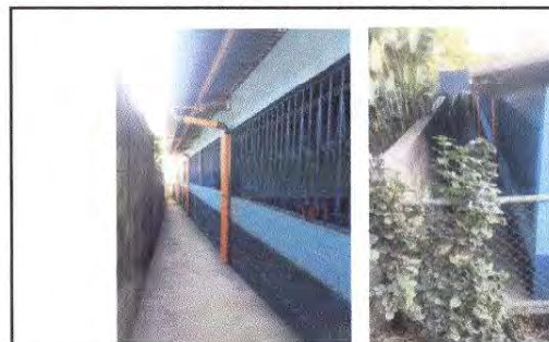
Foto 6: Sustitución e instalación de canales y tubos PVC para aguas pluviales atrás de la aulas
