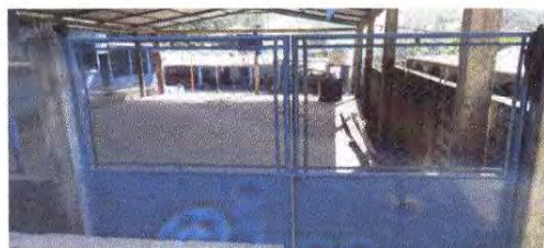
Foto 8: Mantenimiento a portones de metal de entrada principal del establecimiento educativo
