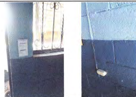
Foto 10: Reparación de cableado eléctrico dentro y fuera de las aulas
