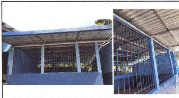
Foto 2: Sustitución de lámina por lámina troquelada Aluzin calibre 26 en aula; sustitución de estructura de soporte de madera por metal en aula
