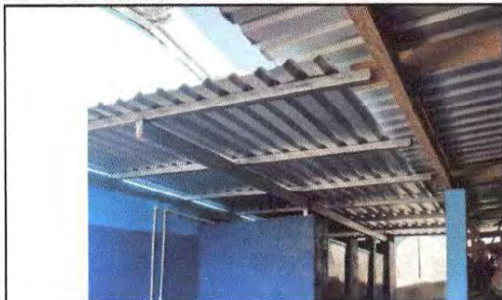
Foto 1: Sustitución de lámina por lámina troquelada Aluzin calibre 26 en servicio sanitario; sustitución de estructura de soporte de madera por metal en servicio sanitario
