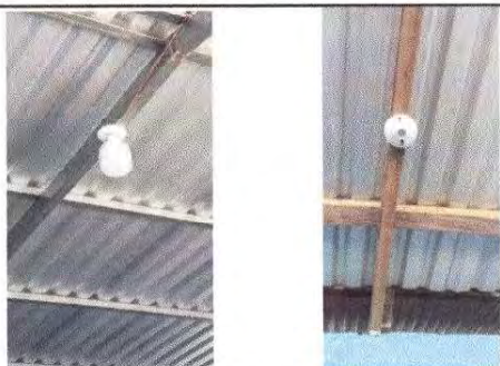
Foto 9: Sustitución de focos ahorradores, sustitución de plafoneras dentro y fuera de las aulas
